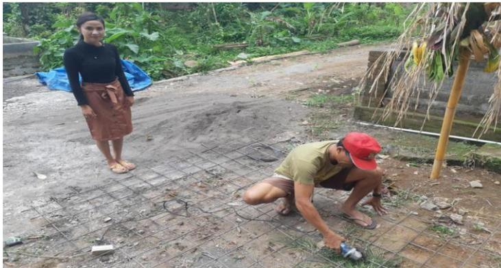
Gambar 1. proses pemotongan besi untuk pembuatan kolam
