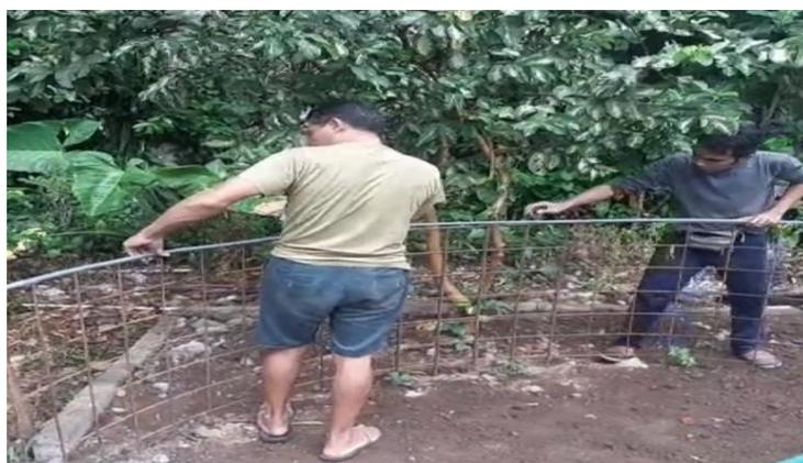
Gambar 2. proses pengulatan besi untuk pembuatan kolam
