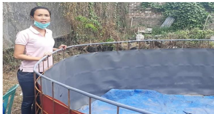
Gambar 3. proses pemasangan terpal untuk pembuatan kolam
