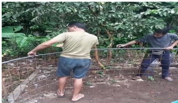
Gambar 2. proses pengulatan besi untuk pembuatan kolam
