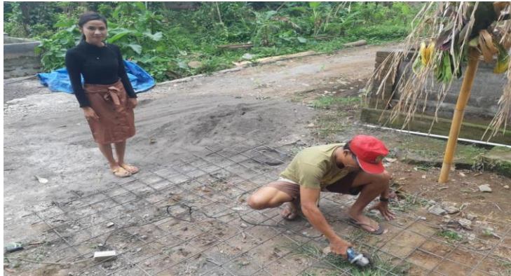
Gambar 1. proses pemotongan besi untuk pembuatan kolam
