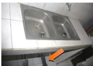
Gambar 7. Wastafel dengan kran yang dioperasikan menggunakan pedal kaki (tanda panah)
