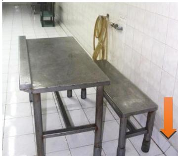
Gambar 12. Sudut pertemuan lantai dan dinding dipasang keramik dengan posisi miring (tanda panah)
