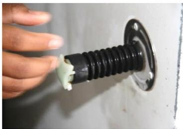
Gambar 5. Alat pembuka pintu dari dalam yang terdapat fosfor
